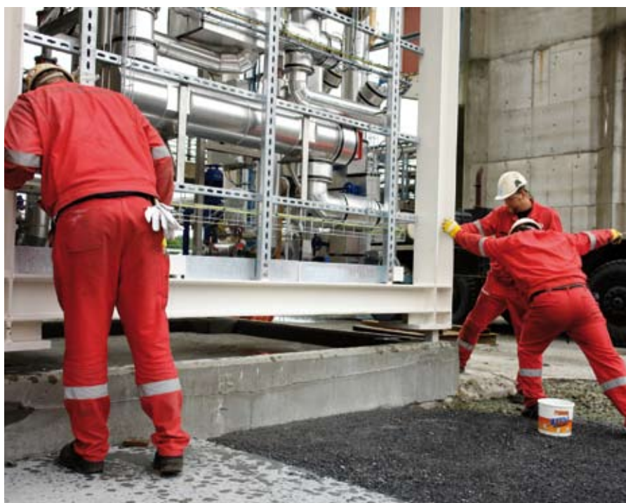
TÅRN: Plassering av tårnet mot fundamentet: alt passet.
