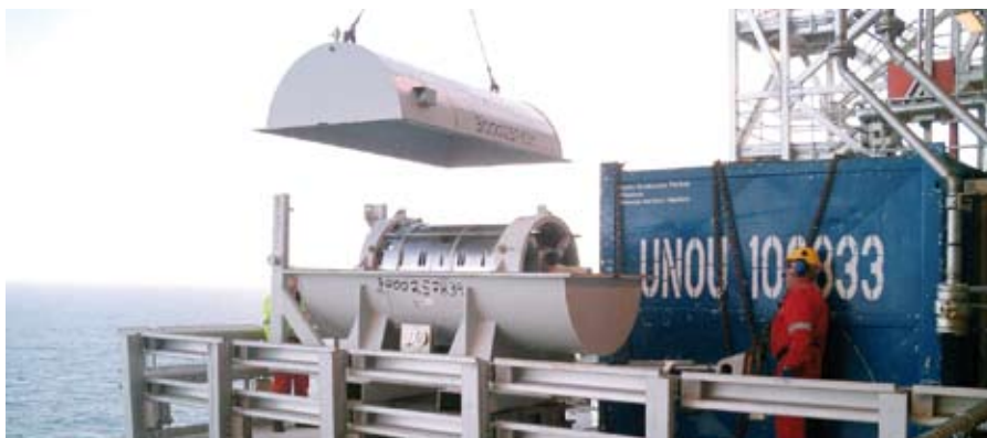
KOMPRESSOR: Innløft av ny kompressor-bundle på Grane.
